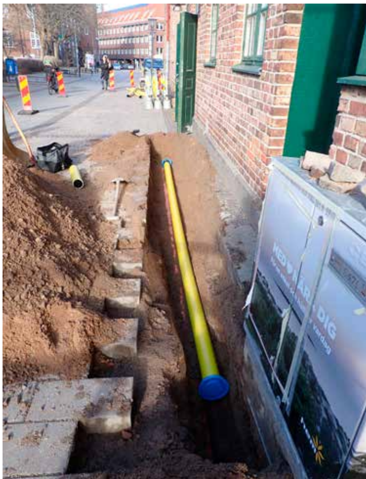
Figur 3. Schaktet på östra sidan om Köpmansgatan vid elskåpet. Mot norr. (Fotonr. 2025-028-1). Foto: Sofie Renström.
